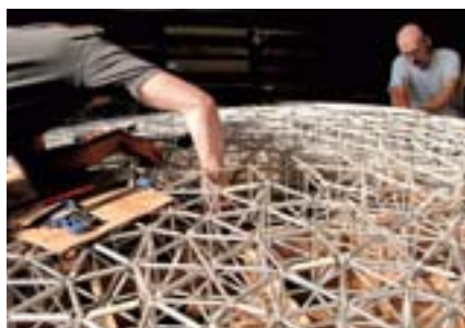
Zusammenbau der einzelnen Module
