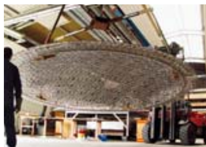
Die fertige Primärstruktur vor dem Beplanken
